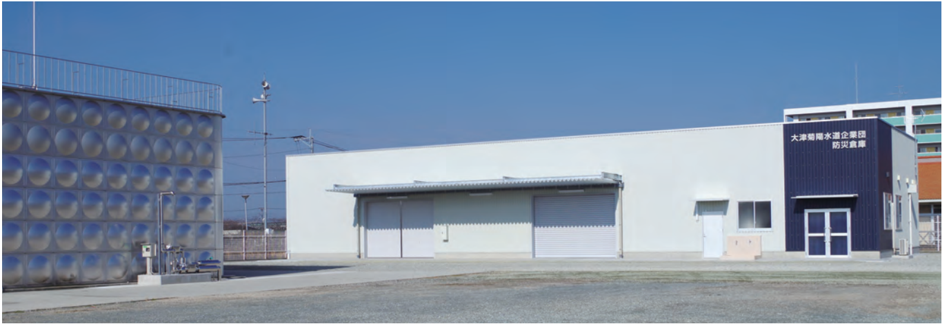
防災倉庫の全景
