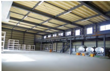
防災倉庫の内部
